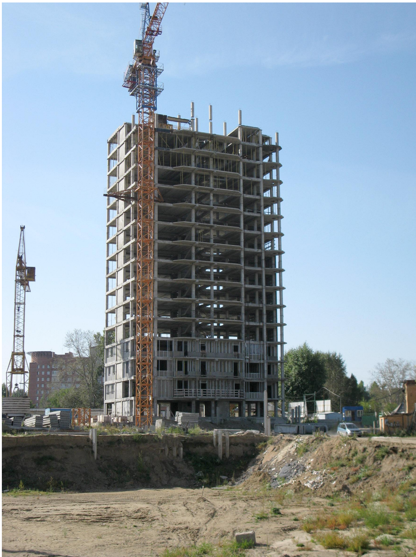
Строительство первого дома по технологии РЕКОН в г. Томске
