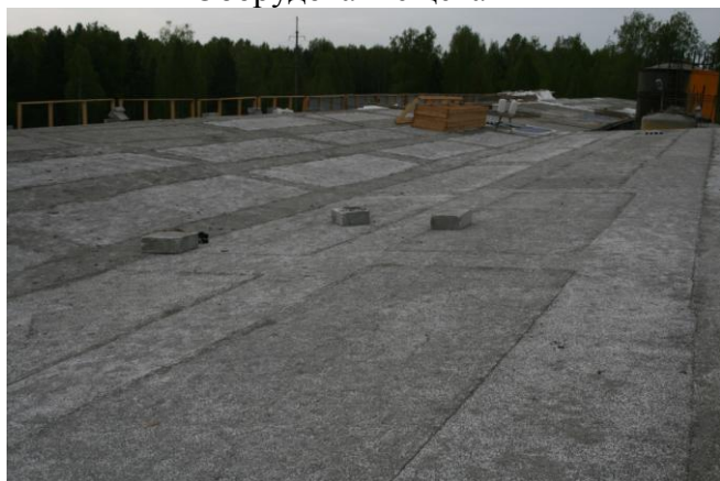
Устройство теплоизоляционного слоя кровли из полистиролбетона марки D 250
