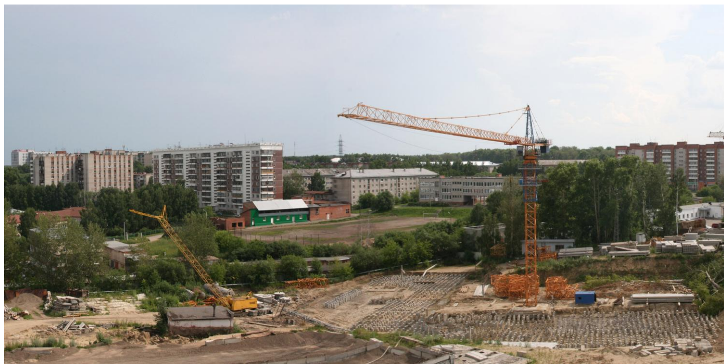
Панорама строительной площадки
