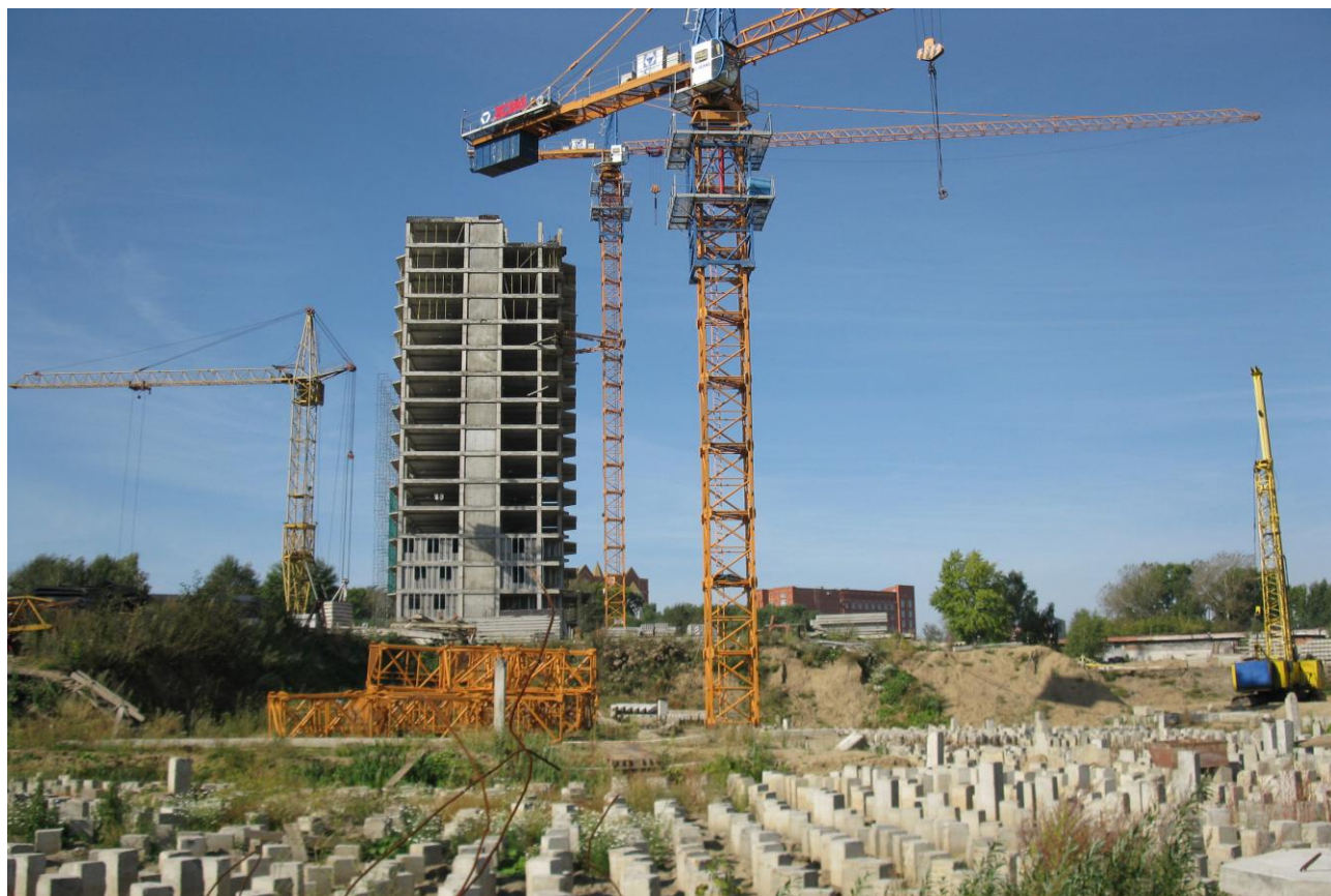
Вид строительной площадки микрорайон Мокрушинский.
