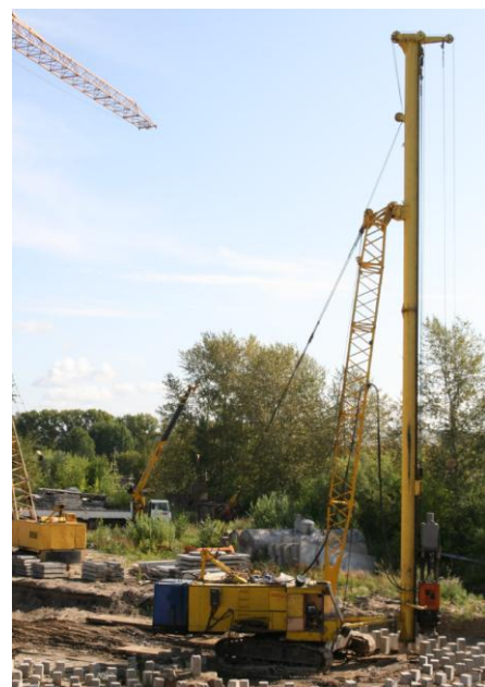
Сваебойный агрегат –гидромолот техника нового поколения
