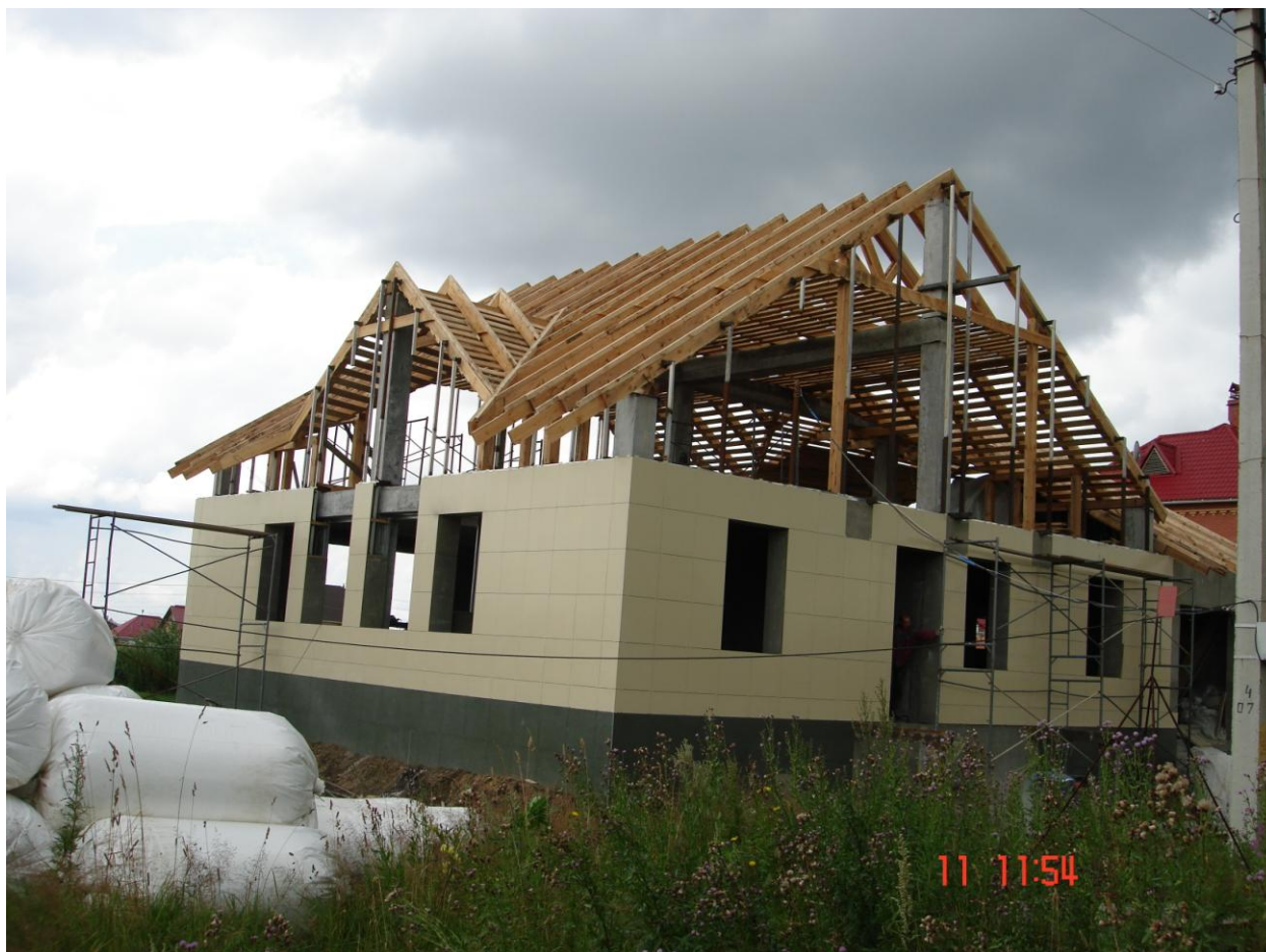
При устройстве стен дома не требуется крана. Раствор полистиролбетона подается насосами. Срок заливки стен жилого дома – 7 дней.
