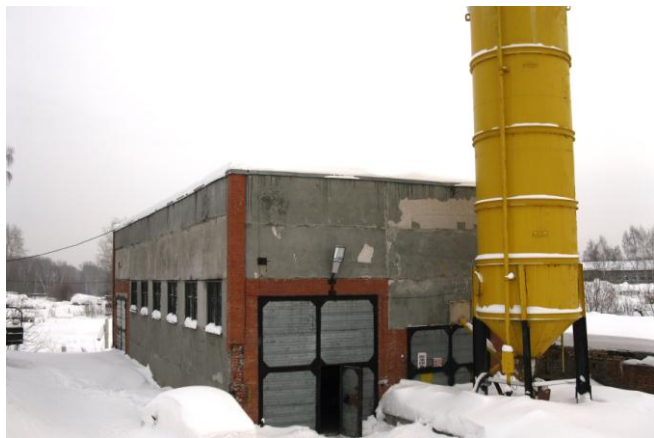
Вид цеха ПСБ
