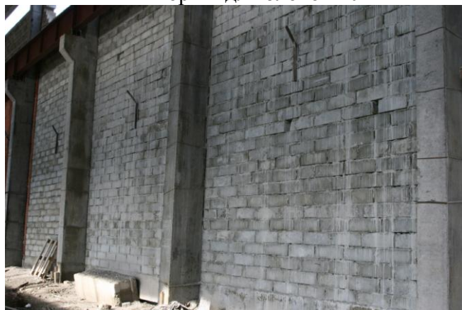
Устройство наружных стен высотой до 12 м из полистиролбетона марки D 400
