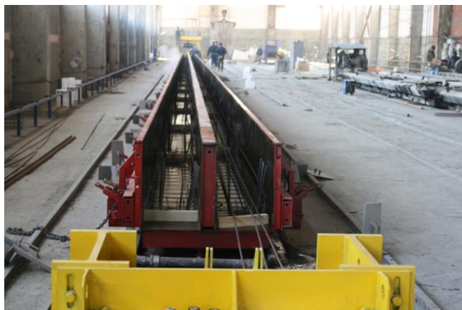
Линия формирования колонн
