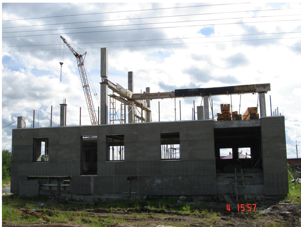
Стены жилого дома возводит бригада из 4-х человек за 15 дней (готовит под заливку). При этом не требуется крана. Все элементы устанавливаются вручную.
